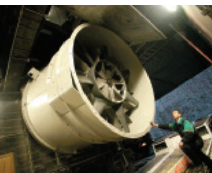
Belchentunnel Einbau Ventilator beim Nordportal im Dezember 2002
