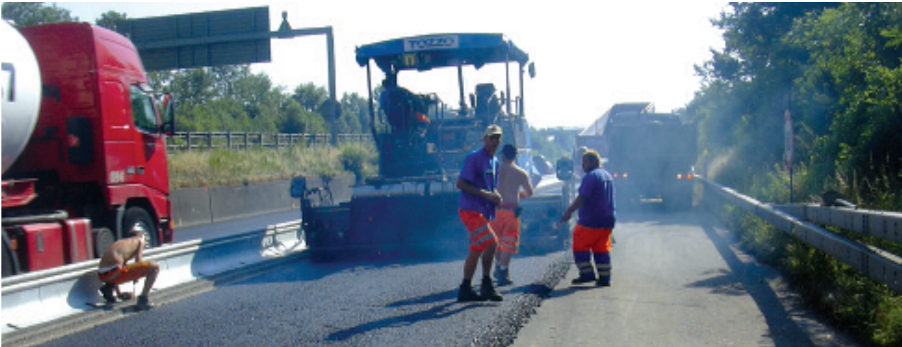
Belageinbau auf der A2 Basel–Augst
