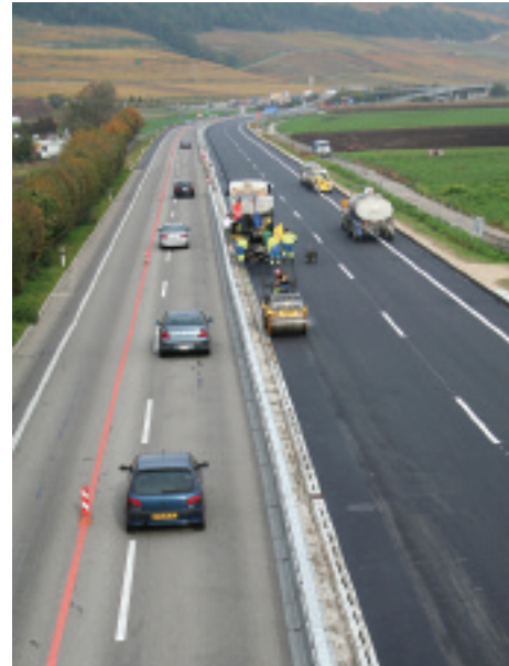
Cressier Einbau Deckbelag im Mittelstreifen
