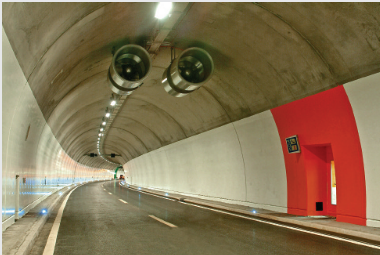
Der 2005 fertigestellte Glion-Tunnel
