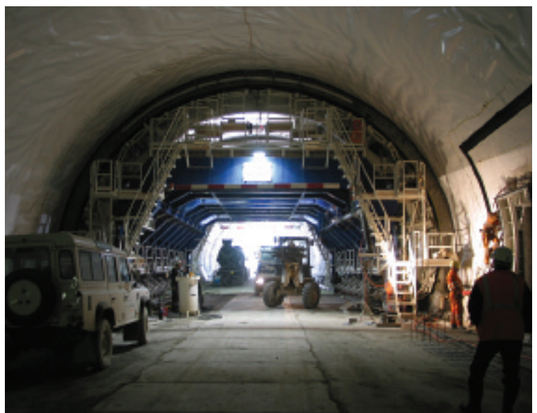
Unten Uetlibergtunnel Schalung für den Einbau des Gewölbebetons
