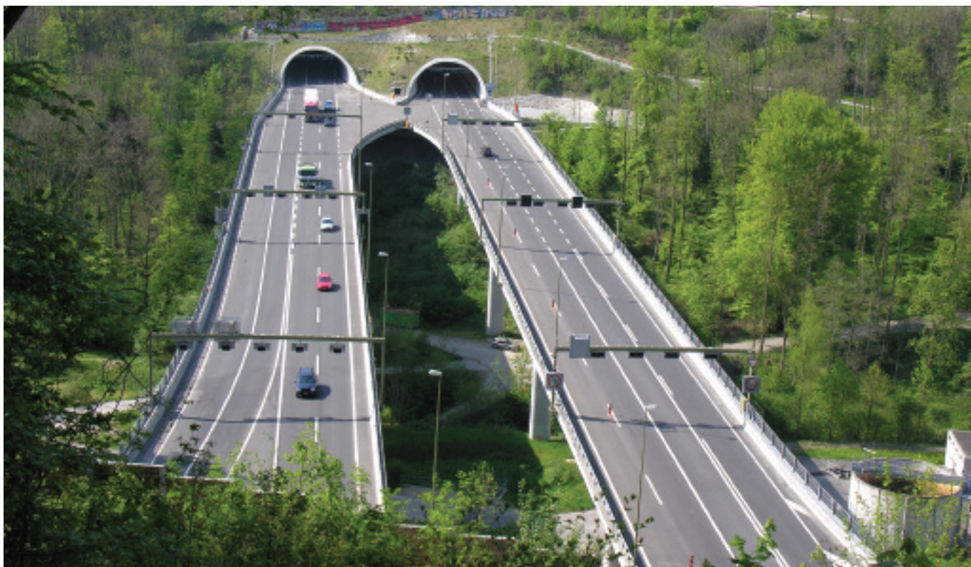
Reppischtalbrücke bei Urdorf
