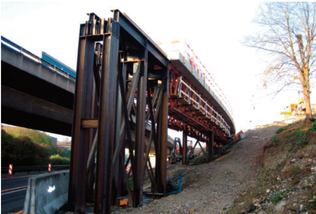
Montage der Hilfsbrücke Verzweigung Augst Oktober 2005
