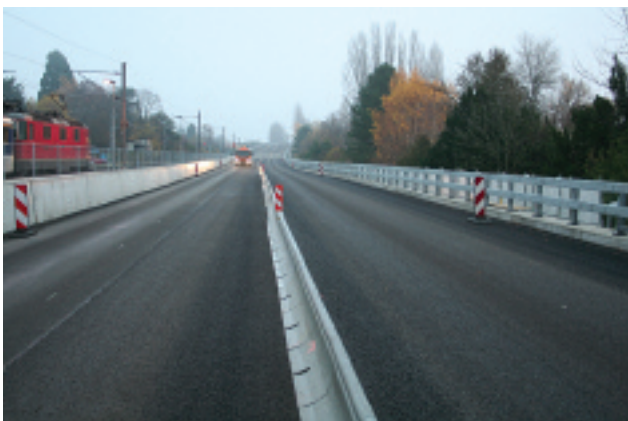
links La Neuveville Reinigung der Fahrbahn
