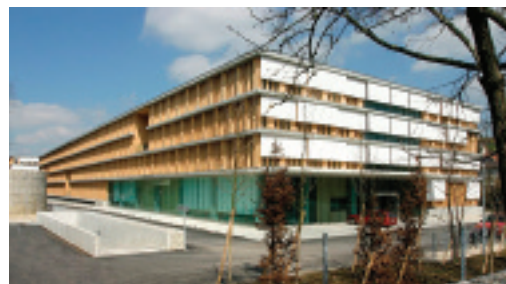
Das neue ASTRA-Verwaltungsgebäude in Ittigen (Bezug im Oktober 2005)
